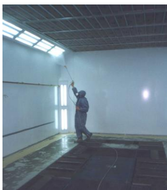
Нанесение защитного состава
