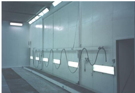
Стены после нанесения защитного состава
